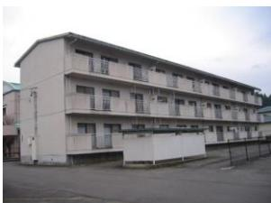
鉄筋コンクリート造 3 階建て（1 棟）、延床面積 836 m<sup>2</sup>。平成 3 年に新耐震基準で建設した営林署公務員宿舎を平成 16 年に取得した建物で、建築から 28 年経過しています。
