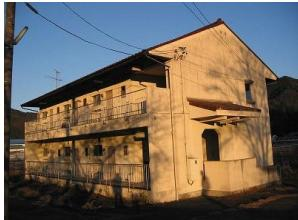
鉄筋コンクリート造 2 階建て（1 棟）、延床面積 406 m<sup>2</sup>。昭和 54 年に旧耐震基準で建設した建物で、平成 27 年に内外装の改修を行っていますが、建築から 40 年経過し老朽化が進んでいます。
