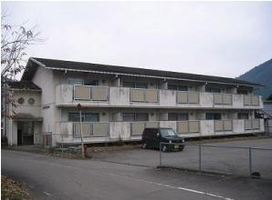
鉄筋コンクリート造 2 階建て（1 棟）、延床面積 374 m<sup>2</sup>。昭和 60 年に新耐震基準で建設した建物で、建築から 34 年経過し老朽化が進んでいます。
