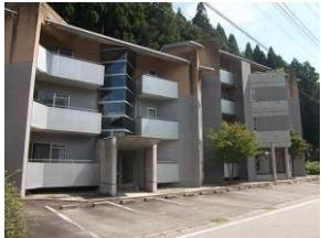
鉄筋コンクリート造 4 階建て（1 棟）、延床面積 782 m<sup>2</sup>。平成 11 年に新耐震基準で建設した建物で、建築から 20 年経過しています。
