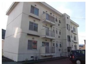
鉄筋コンクリート造 3 階建て（1 棟）、延床面積 535 m<sup>2</sup>。昭和 63 年に新耐震基準で職員宿舎として日本道路公団（現中日本高速道路株）が建設し、平成 17 年に市が取得した建物で、平成 17 年及び平成 27 年に内外装を改修していますが、建築から 31 年経過し老朽化が進んでいます。
