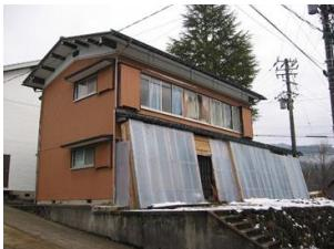
木造 2 階建て（戸建て 1 棟）、延床面積 124 m<sup>2</sup>。昭和 50 年に旧耐震基準で建設した建物で、建築から 44 年経過し老朽化が顕著となっています。
