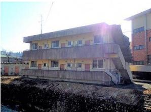
鉄筋コンクリート造 2 階建て（1 棟）、延床面積 352 m<sup>2</sup>。昭和 53 年に旧耐震基準で建設した建物で、建築から 41 年経過し老朽化が顕著となっています。
