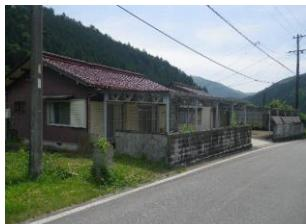
小川教職員住宅 B は、昭和 51 年に旧耐震基準で建設した、木造平屋建て（戸建て 1 棟、延床面積 62 m<sup>2</sup>）の 3 号棟と、昭和 57 年に新耐震基準で建設した木造平屋建て（1 棟、2 戸、延床面積 75 m<sup>2</sup>）の 4・5 号棟で構成する建物で、延床面積合計 137 m<sup>2</sup>。建築から 37 年～43 年が経過し老朽化が進んでいます。
