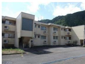
鉄筋コンクリート造 2 階建て（1 棟）、延床面積 914 m<sup>2</sup>。昭和 55 年に旧耐震基準で建設した建物で、耐震診断の結果耐震基準は満たしており、平成 20 年から平成 21 年にかけて内外装等の改修を行っていますが、建築から 39 年経過し老朽化が進んでいます。
