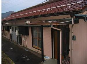
木造平屋建て（1 棟）、延床面積 104 m<sup>2</sup>。昭和 47 年に旧耐震基準で建設した建物で、建築から 47 年経過し老朽化が顕著となっています。
