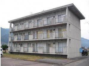
鉄筋コンクリート造 3 階建て（1 棟）、延床面積 762 m<sup>2</sup>。昭和 52 年に旧耐震基準で建設した建物で、建築から 42 年経過し老朽化が進んでいます。
