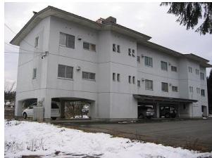
鉄筋コンクリート造 3 階建て（1 棟）、延床面積 520 m<sup>2</sup>。昭和 53 年に旧耐震基準で建設した建物で、平成 27 年に内装等の一部改修を行っていますが、建築から 41 年経過し老朽化が顕著となっています。
