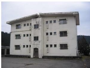
鉄筋コンクリート造 3 階建て（1 棟）、延床面積 533 m<sup>2</sup>。昭和 49 年に旧耐震基準で建設した建物で、建築から 45 年経過し老朽化が顕著となっています。
