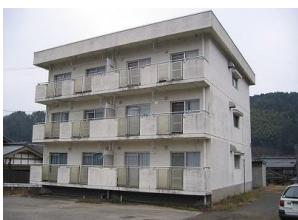
鉄筋コンクリート造 2 階建て（1 棟）、延床面積 397 m<sup>2</sup>。昭和 58 年に新耐震基準で建設した建物で、建築から 36 年経過し老朽化が進んでいます。（平成 28 年漏水による一部利用休止、平成 29 年改修工事実施）
