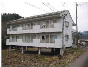
鉄骨造 2 階建て (1 棟)、延床面積 233 m<sup>2</sup>。昭和 63 年に新耐震基準で建設した建物で、平成 27 年に屋根外壁塗装の改修を行っていますが、建築から 31 年経過し老朽化が進んでいます。
