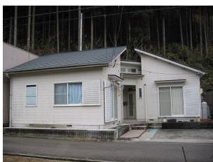
木造平屋建て (1 棟)、延床面積 58 m<sup>2</sup>。平成 5 年に新耐震基準で建設した建物で、建築から 26 年経過しています。
