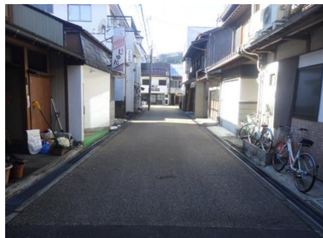
▲着工前(大阪町)
