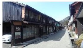
▲施工後(中柳町)
