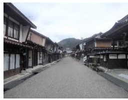
▲施工後(職人町)
