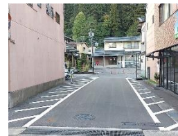
▲施工後(上日吉町)
