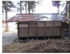
舞台屋根修繕後
