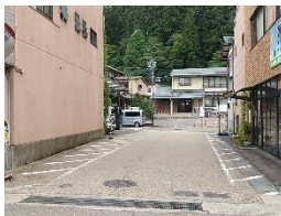
▲施工前(上日吉町)
