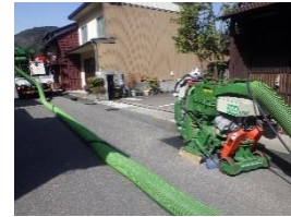
▲ショットブラスト工の施工
