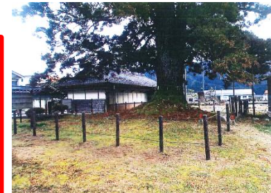
囲い柵 改修後
