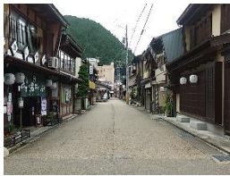
▲施工前(大坂町)
