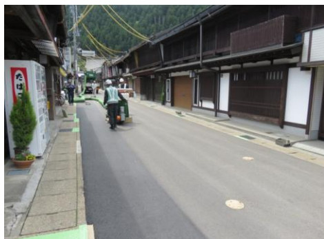
【調査】県道有穂中坪線の施工状況
