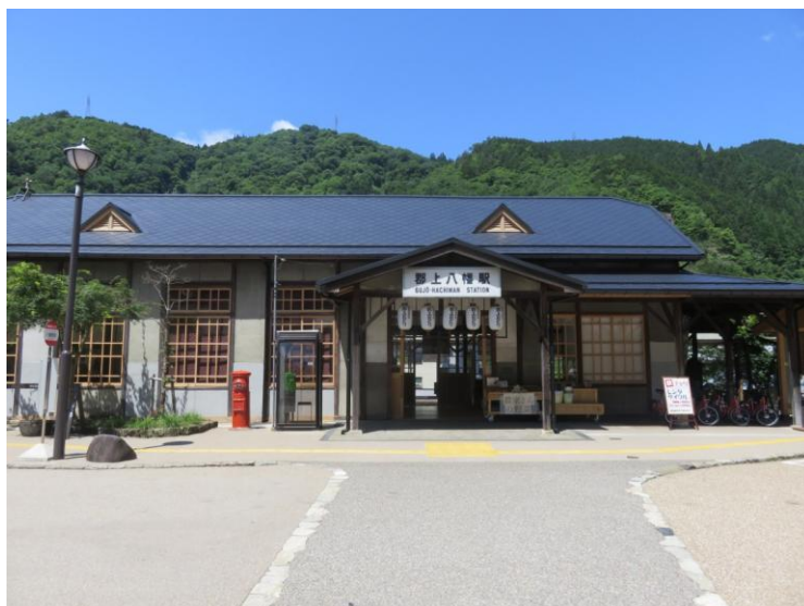
改修工事完成
