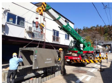
施工状況(電・通共用 I 型特殊部上下分割)
