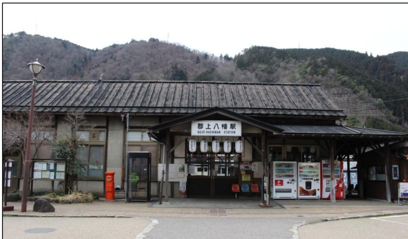
改修工事着工前
