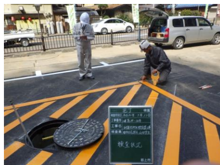
耐震性貯水槽整備工事完了
