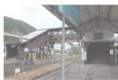
長良川鉄道郡上八幡駅舎 跨線橋
