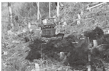
架線集材の様子
