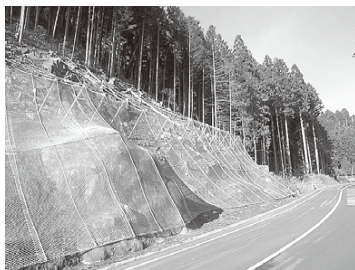
防護網で土砂災害の危険を防ぐ
