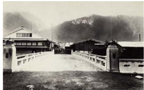
1-3-29 宮ヶ瀬橋(昭和12年)
