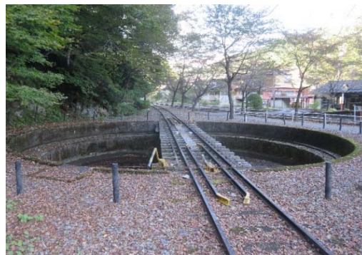
1-4-13 旧国鉄越美南線北濃駅機関車転車台
