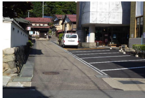
▲施工後(舗装高質化工事)
