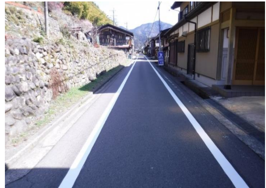
▲施工後写真(尾崎町地内)
