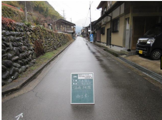
▲施工前写真(尾崎町地内)
