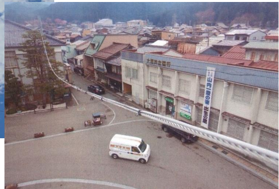
▲修理されたワイヤー
