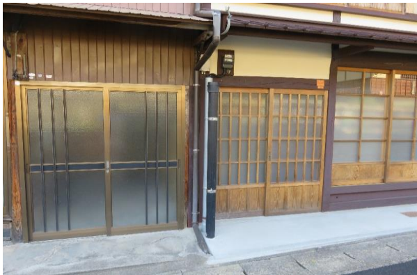
▲完成状況(立上管)
