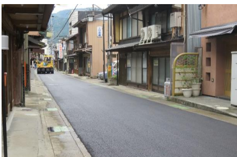
▲施工中(上日吉町) ※表層工
