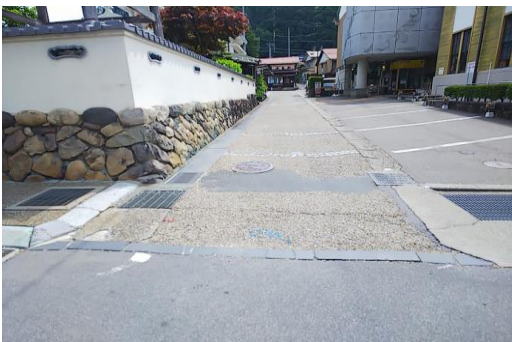
▲施工前(舗装高質化工事)
