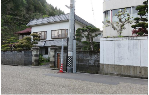
▲完成状況(連系柱、引上管)
