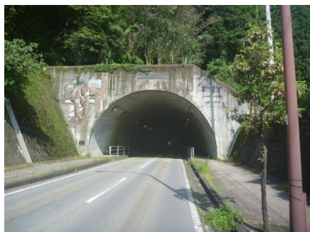
城山トンネル
