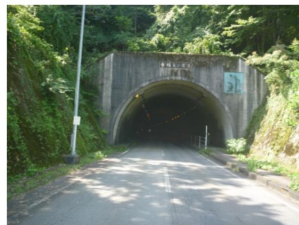
寺坂トンネル
