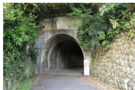
三日市トンネル
