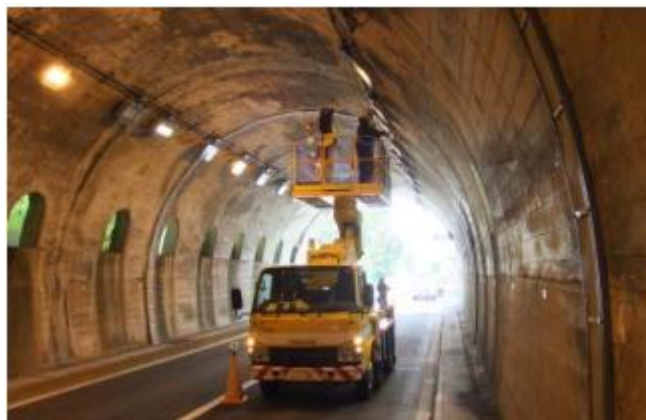
図 3 近接目視作業状況
