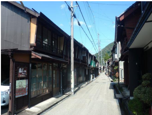
▲施工状況(電線類無電柱化工事、中柳町)
