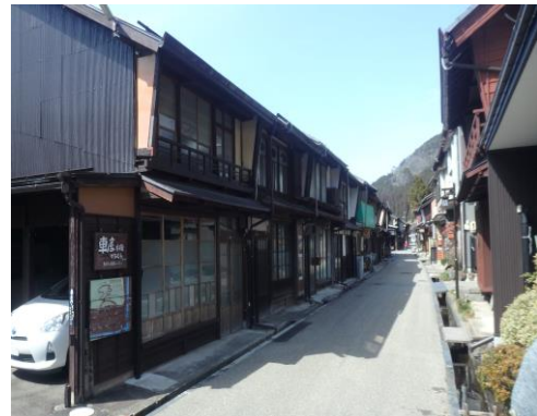
▲施工後(電線類無電柱化工事、中柳町)
