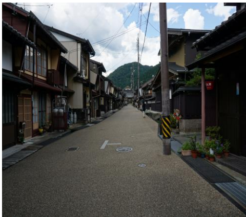
▲施工前(電線類無電柱化工事、職人町)
