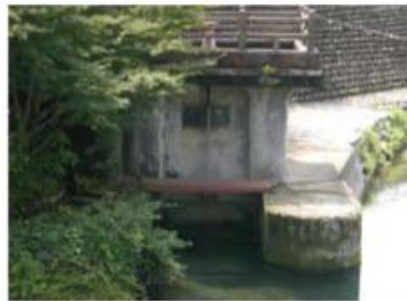
島谷用水路取水口
