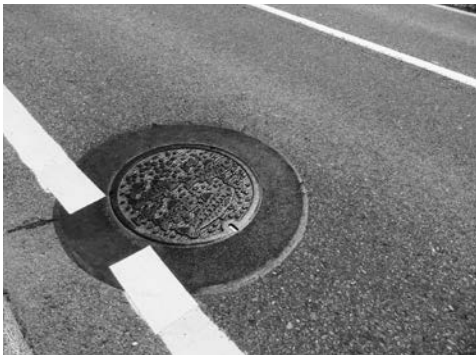
更新されたマンホールの蓋
