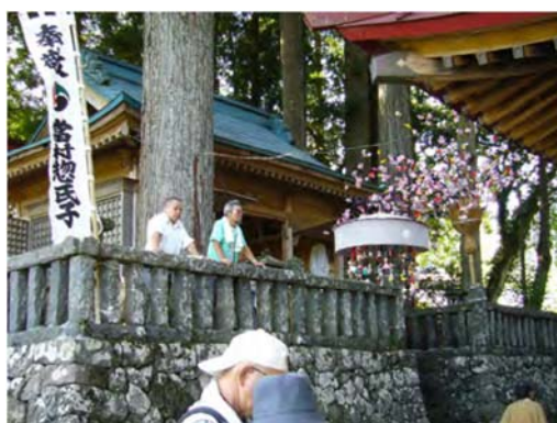
2-8-4 石積と幣殿 (社務所)
