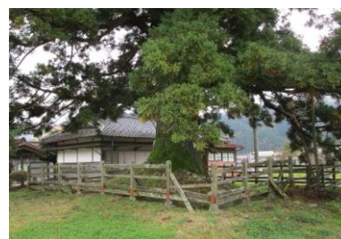
囲い柵 改修前
