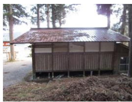
舞台屋根修繕後
