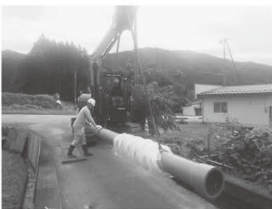
市内で行われた水道の耐震管工事の様子
