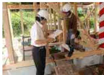
市産材住宅検査状況
