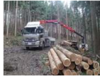
搬出の状況（阿多岐地内）
