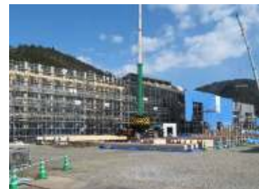
建設中の大和中学校
