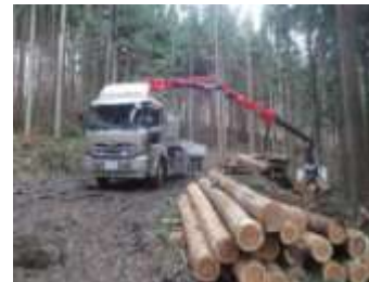
搬出の状況（阿多岐地内）
