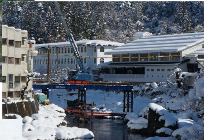
仮設ベント設置状況
