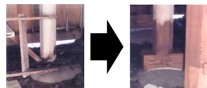
構造材取替工事（前 → 後）
