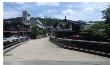
橋梁補修に合わせたカラー舗装
