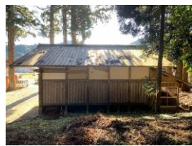
舞台屋根修繕前
