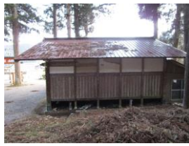
舞台屋根修繕後
