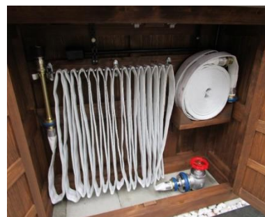
伝建地区の新設消火栓 整備後
