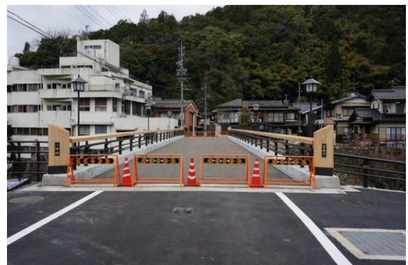
ショットブラスト工法による舗装面修景 八幡橋(学校橋)竣工
