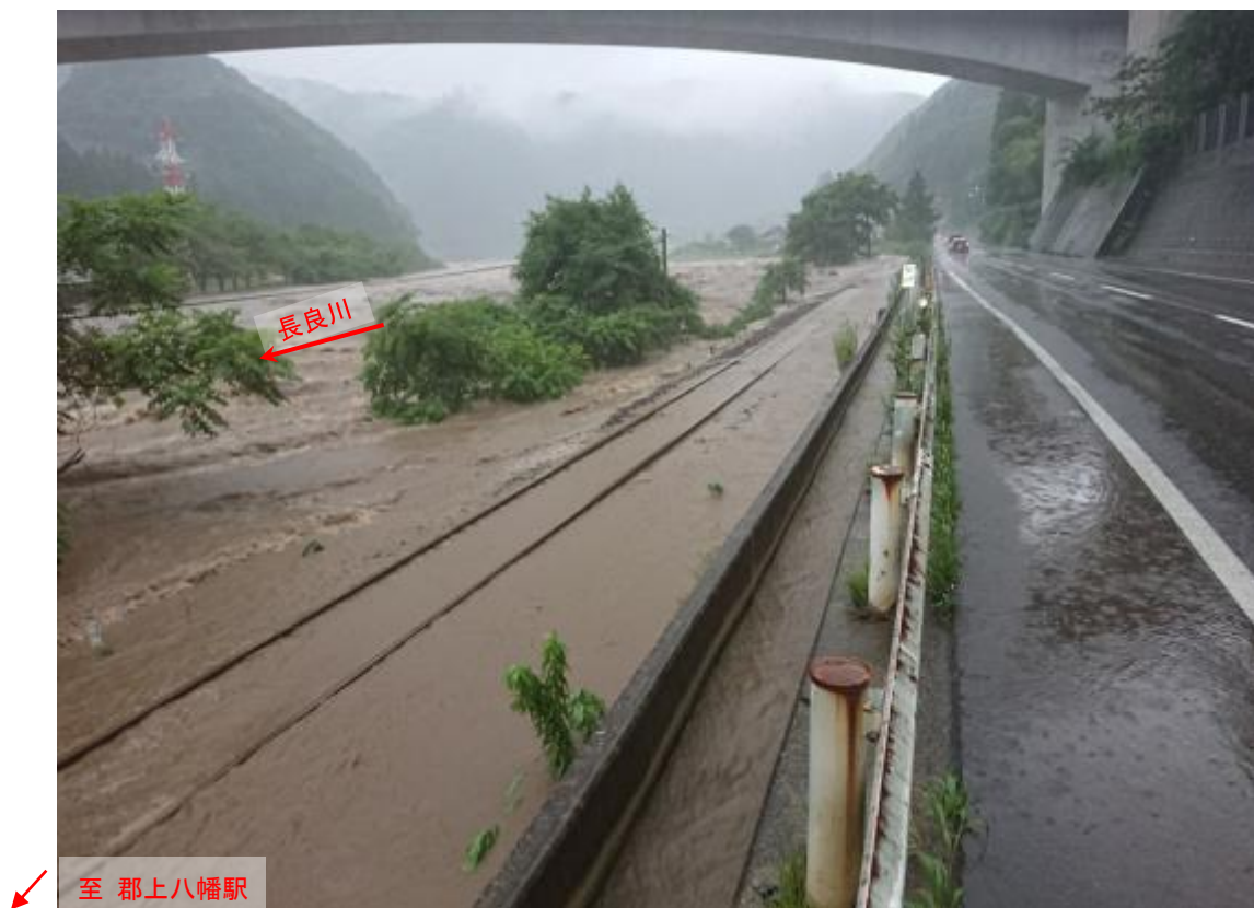
冠水した長良川鉄道（郡上市瀬取地内）
