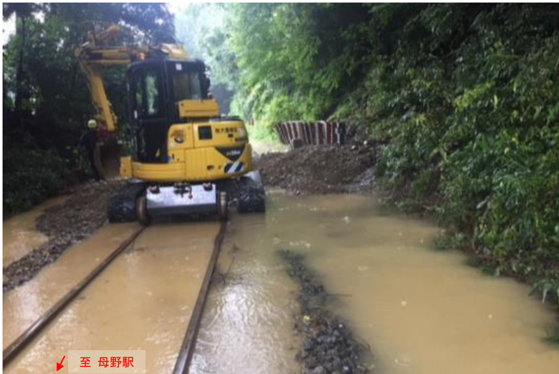
土砂撤去状況 (美濃市須原地内)
