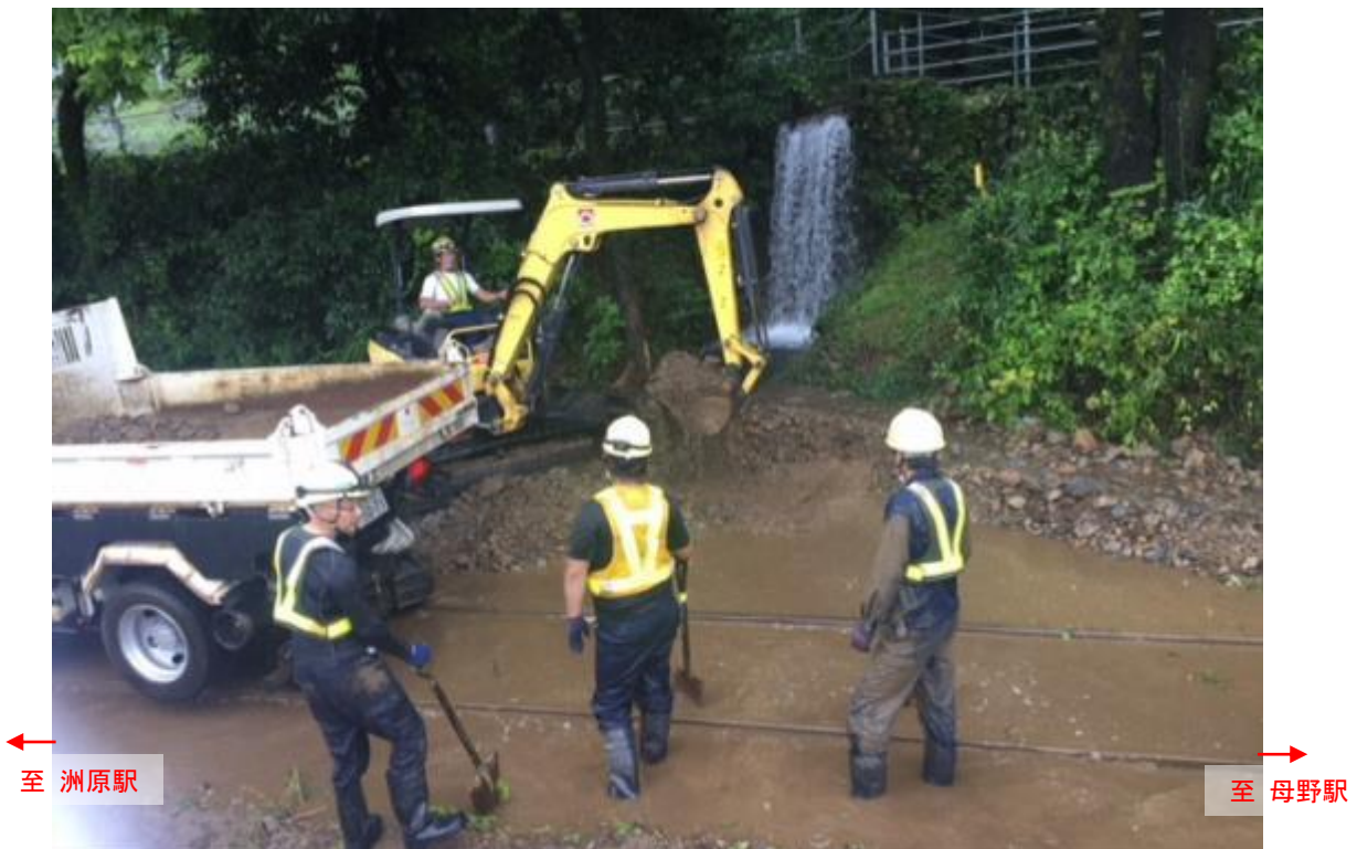
土砂撤去状況 (美濃市須原地内)
