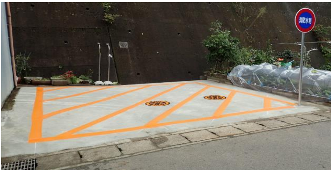
▲完成状況(郡上八幡市街地南部、下櫛形町地内)
