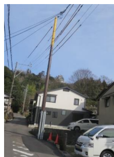
▲完成状況(連系柱、引上管)
