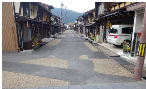
▲着工前(柳町) ※下段のようなカラー舗装
