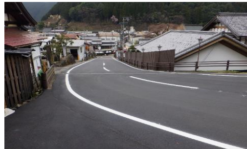
▲一部完了(城山登り口) ※通常のAs舗装
