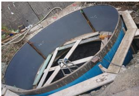
▲施工中の様子
