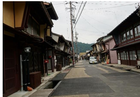
▲完成状況(第4工区管路工事)
