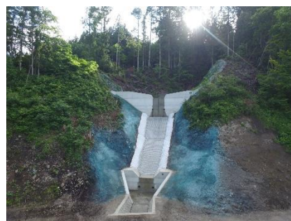
県単治山事業（高鷲町西洞字木洞地内）
