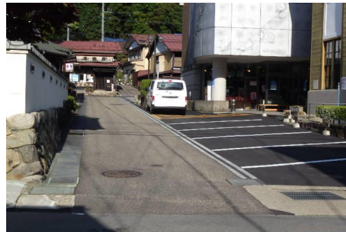
▲施工後(舗装高質化工事)
