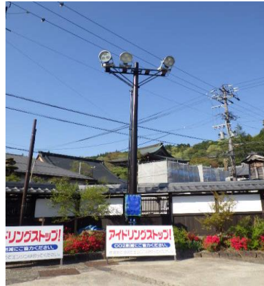
▲完成写真 (城下町プラザ内)
