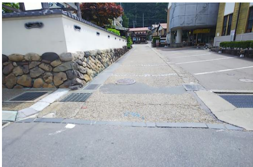
▲施工前(舗装高質化工事)
