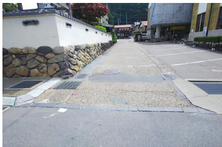
▲着工前(博覧館入り口)
