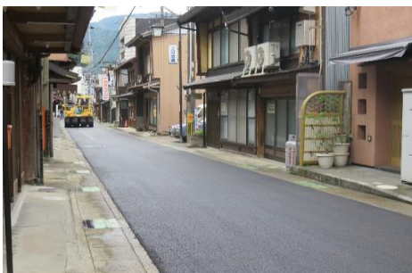
▲施工中(上日吉町) ※表層工
