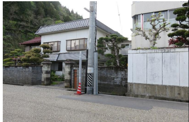
▲完成状況(連系柱、引上管)
