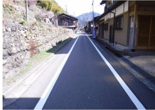
▲施工後写真(尾崎町地内)
