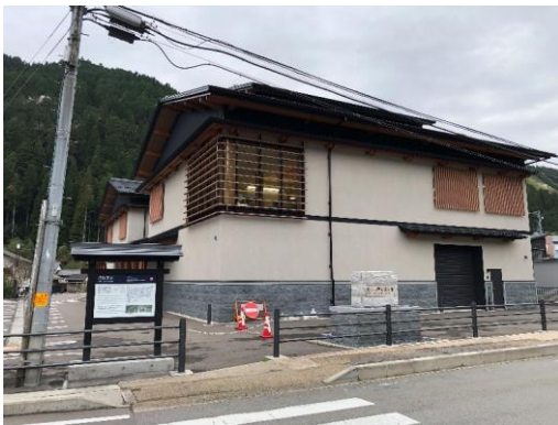
▲ 状況写真(北町用水) 郡上市歴史資料館
