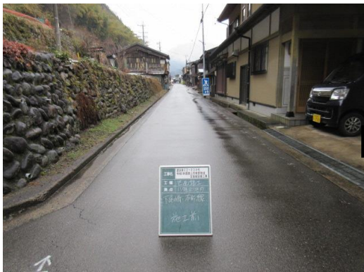
▲施工前写真(尾崎町地内)
