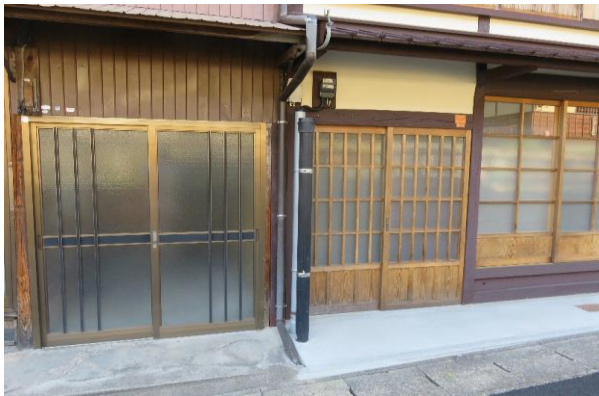
▲完成状況(立上管)
