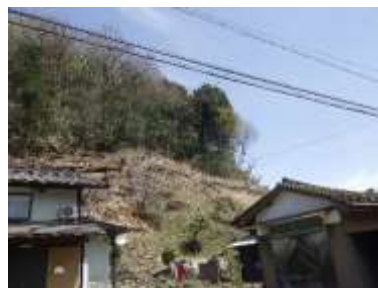
整備後の状況（大和町）
