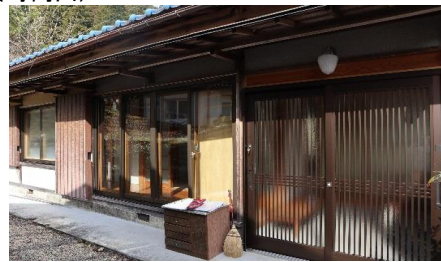
▲改修後の玄関・外観
