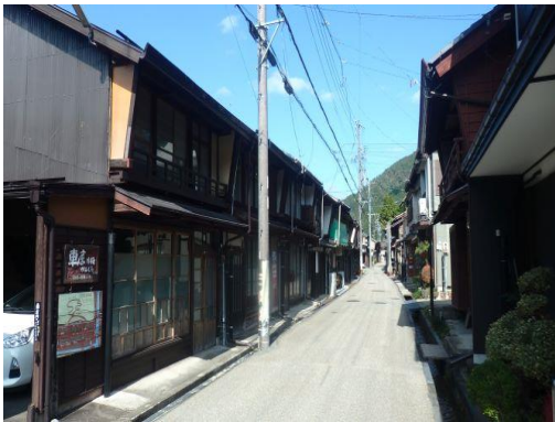
▲施工状況(電線類無電柱化工事、中柳町)
