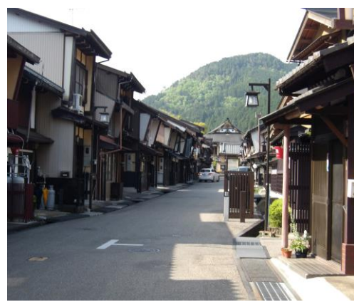
▲施工後(電線類無電柱化工事、職人町)
