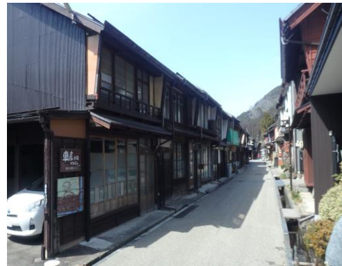
▲施工後(電線類無電柱化工事、中柳町)
