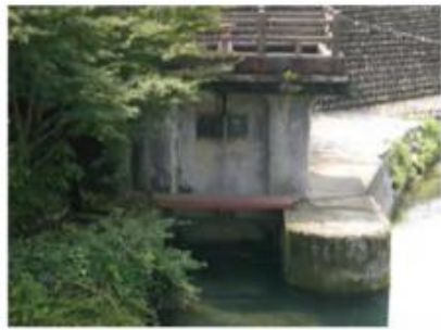
島谷用水路取水口
