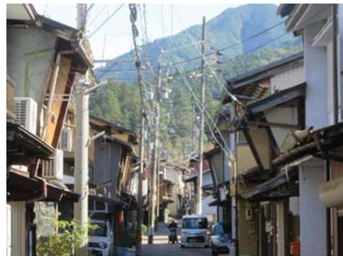
3-1-9 狭く往来の多い道路にはみだしている電柱
