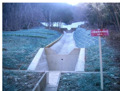
県単治山事業（落差工）
