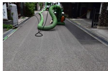
ショットプラスト工法による舗装面修景
