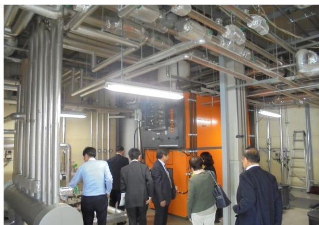
一の橋地区地域熱供給システムの木質ボイラー
