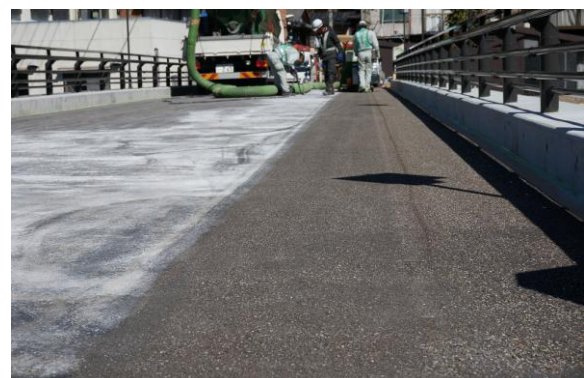
ショットブラスト工法による舗装面施工 八幡橋(学校橋)
