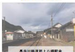
長良川鉄道郡上八幡駅舎 プラットフォーム
