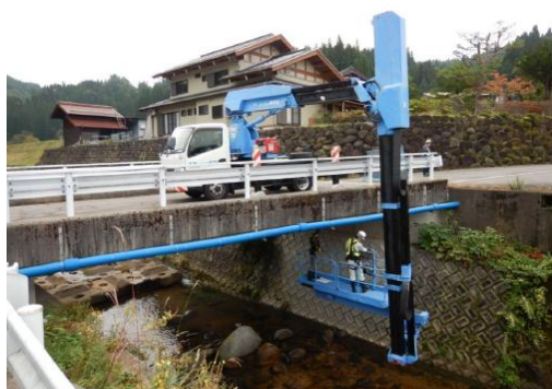
橋梁点検車による近接目視点検
