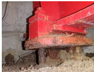
省座モルタル欠損、支承腐食・防食機能の劣化
