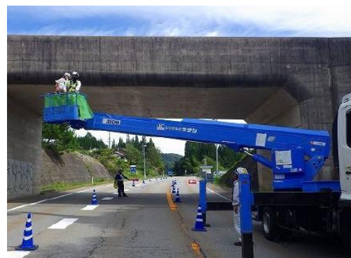
高所作業車による近接目視点検
