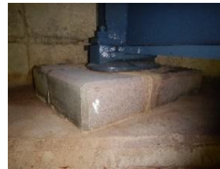
モルタル補修、塗装塗替
