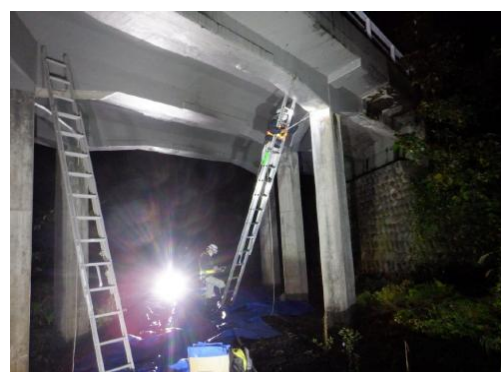
触診による劣化状況の調査
