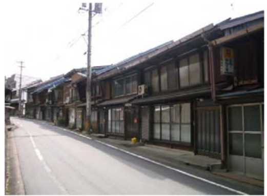
2-1-44 尾崎町 通りからみた町並み
