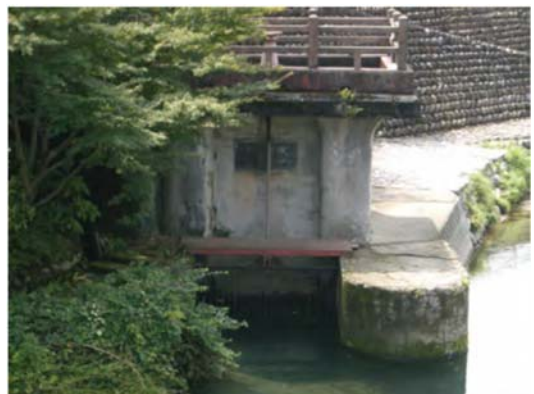
2-1-28 島谷用水取水口 (昭和12年改修)
