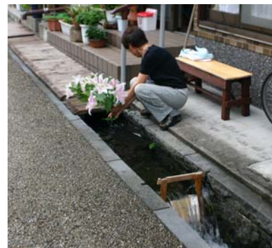
2-1-41 セギで水を溜めて使用する様子
