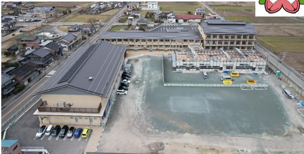
大和小学校 外観（令和6年3月19日現在 ドローンにて撮影）と校章
