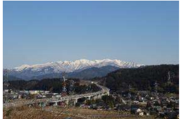
白鳥地内を縦断する東海北陸自動車道
