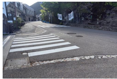
▲完了後(市道殿町・下小野線) ※ショットブラスト工
