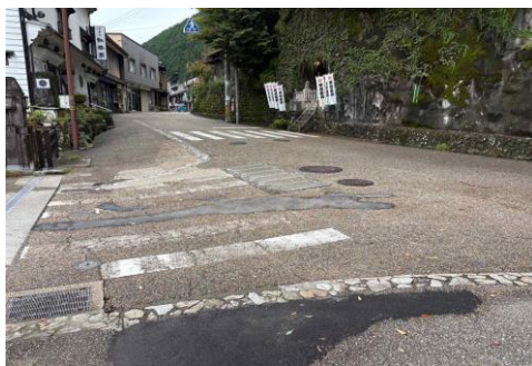
▲着工前(市道殿町・下小野線)
