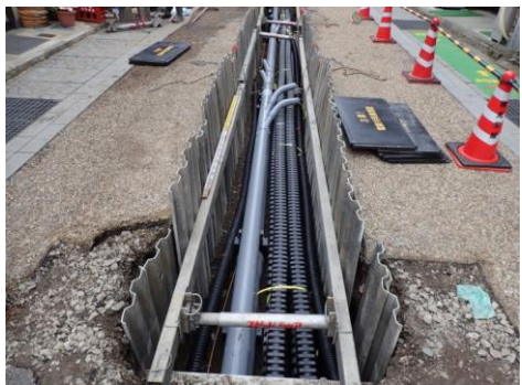
施工状況(管路布設 左:通信用、右:電力用)
