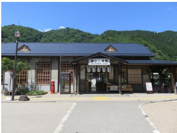
改修工事完成
