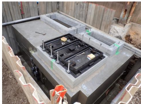
施工状況(地上機器特殊部ハンドホール)
