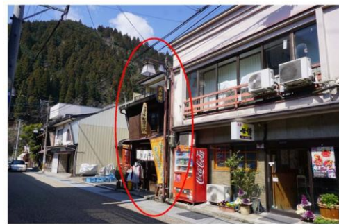
調査箇所④ 大手町
