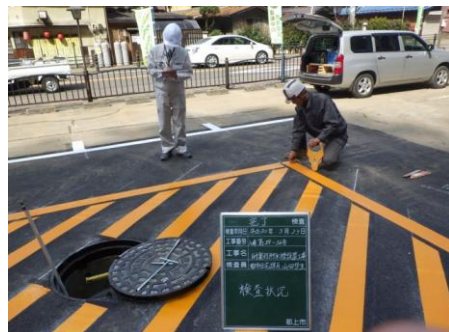
耐震性貯水槽整備工事完了
