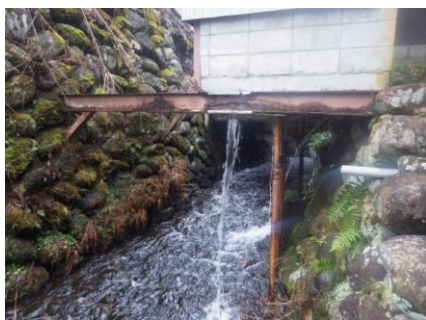
カワド改修前
