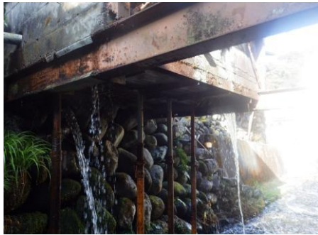
カワド改修前
