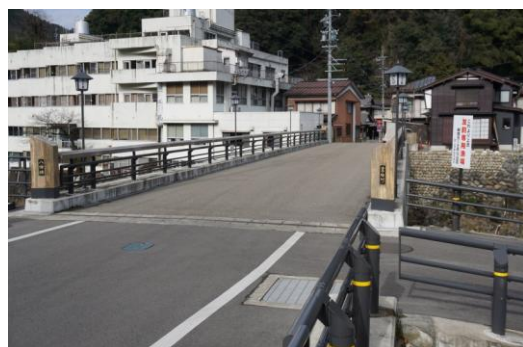
【調査】施工から2年半が経過した八幡橋
