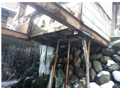
カワド改修前
