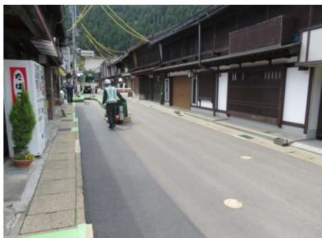
【調査】県道有穂中坪線の施工状況
