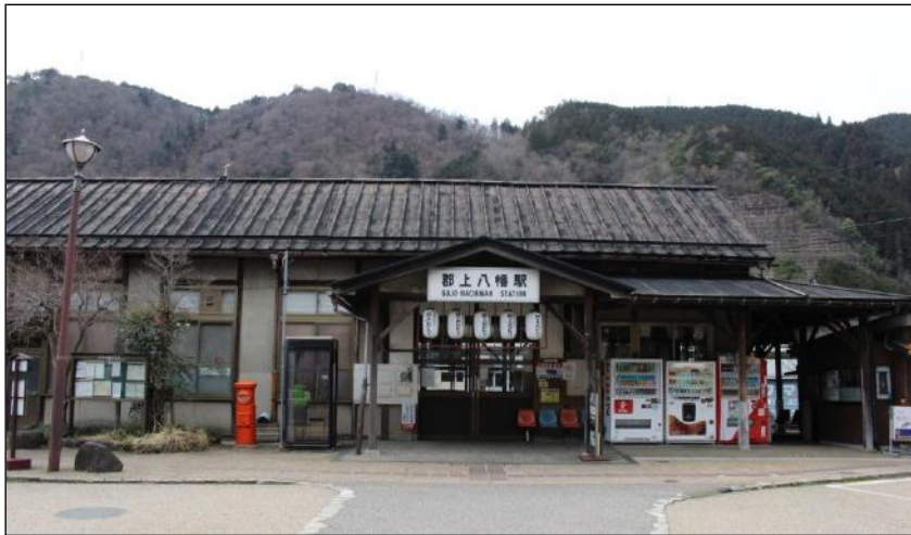
改修工事着工前
