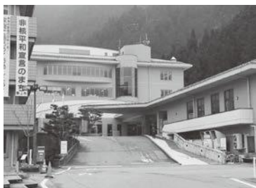
郡上市役所本庁舎
