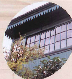
レントゲン棟の屋根に施された飾り破風
