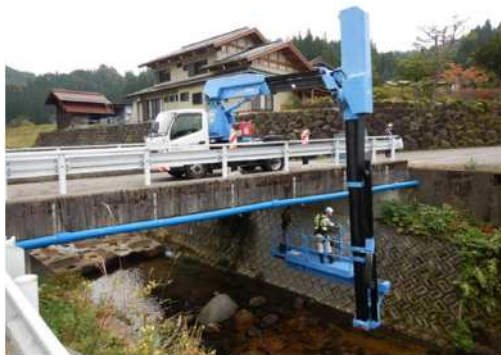
橋梁点検車による近接目視点検
