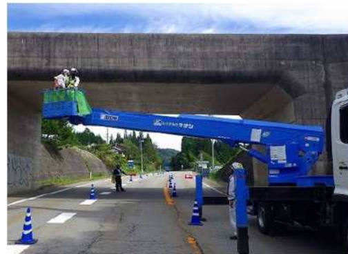
高所作業車による近接目視点検
