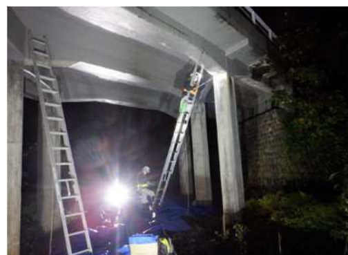
触診による劣化状況の調査
