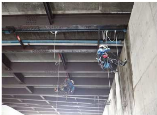
特殊高所技術による近接目視点検
