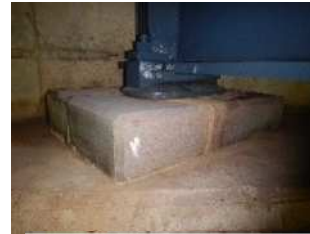
モルタル補修、塗装塗替
