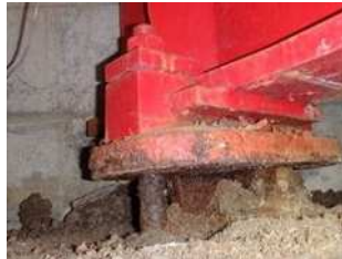
省座モルタル欠損、支承腐食・防食機能の劣化
