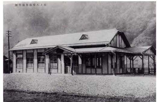
1-3-21 郡上八幡駅(昭和4年)
