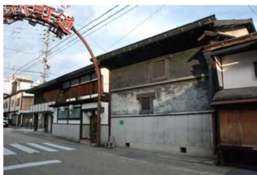
2-2-6 直井家住宅主屋、土蔵（新町側）
