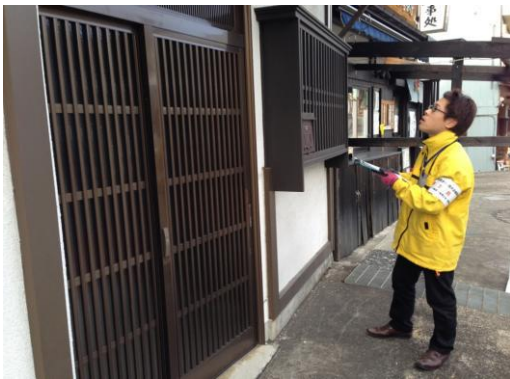
空き家・空き店舗の目視調査
