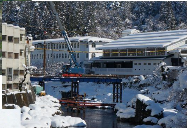
仮設ペント設置状況
