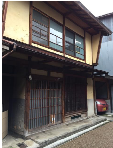
改修中の家屋の外観
