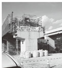
工事が進む濃飛横断自動車道・中津川工区
