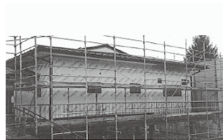
市民の安全を守る耐震工事
