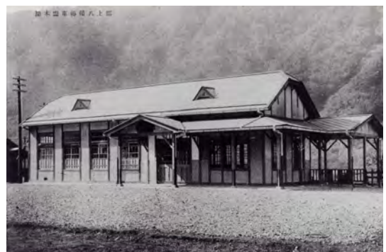
1-4-30 郡上八幡駅（昭和 4 年）
