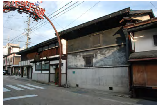
2-2-19 直井家住宅主屋、土蔵（新町側）
