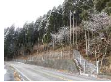
八幡町初納地内（不要木除去後）
