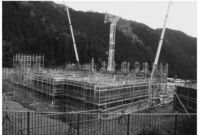
郡上クリーンセンター建設始まる(八幡町有坂)
