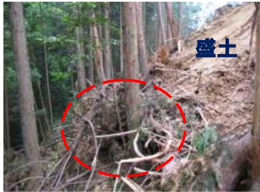
写真6-1-1 盛土のり面と地山とのすり付き先が枝葉や丸太などの集積物であるもの
